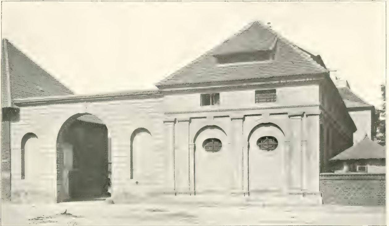
Einfahrt und Wirtschaftsgebäude beim Amt Wörlitz nach 1770.
